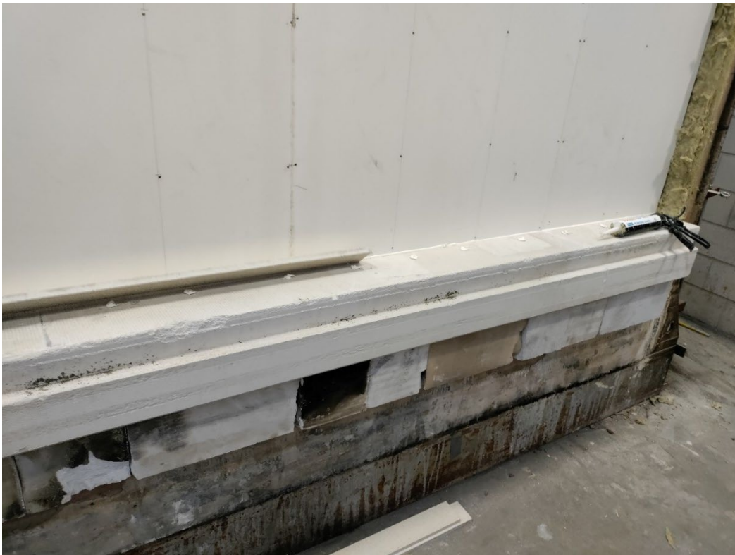
Foto C. 12: Verlegung und Versiegelung der Magoxx- und Fermacell-Bodenplatten.
