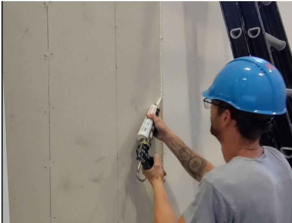
Foto C. 11: Platzierung der MAGOXX®Board s (unbelichtete Seite)
