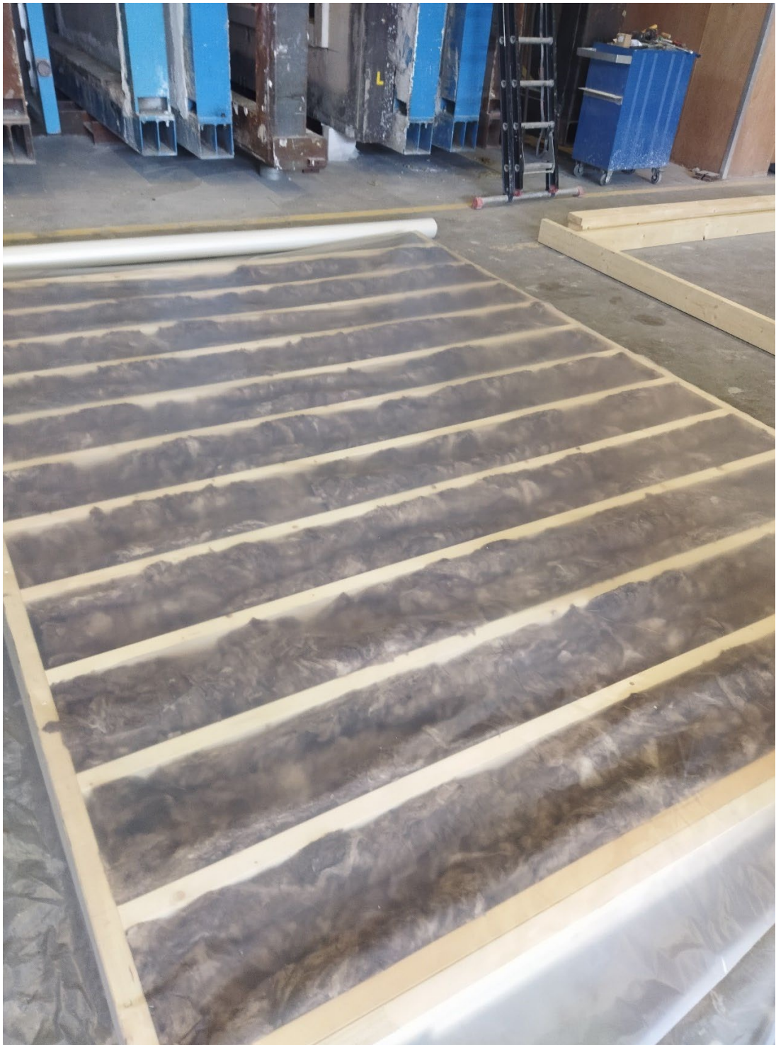
Foto C. 3: Anbringung von Dämmung und Folie
