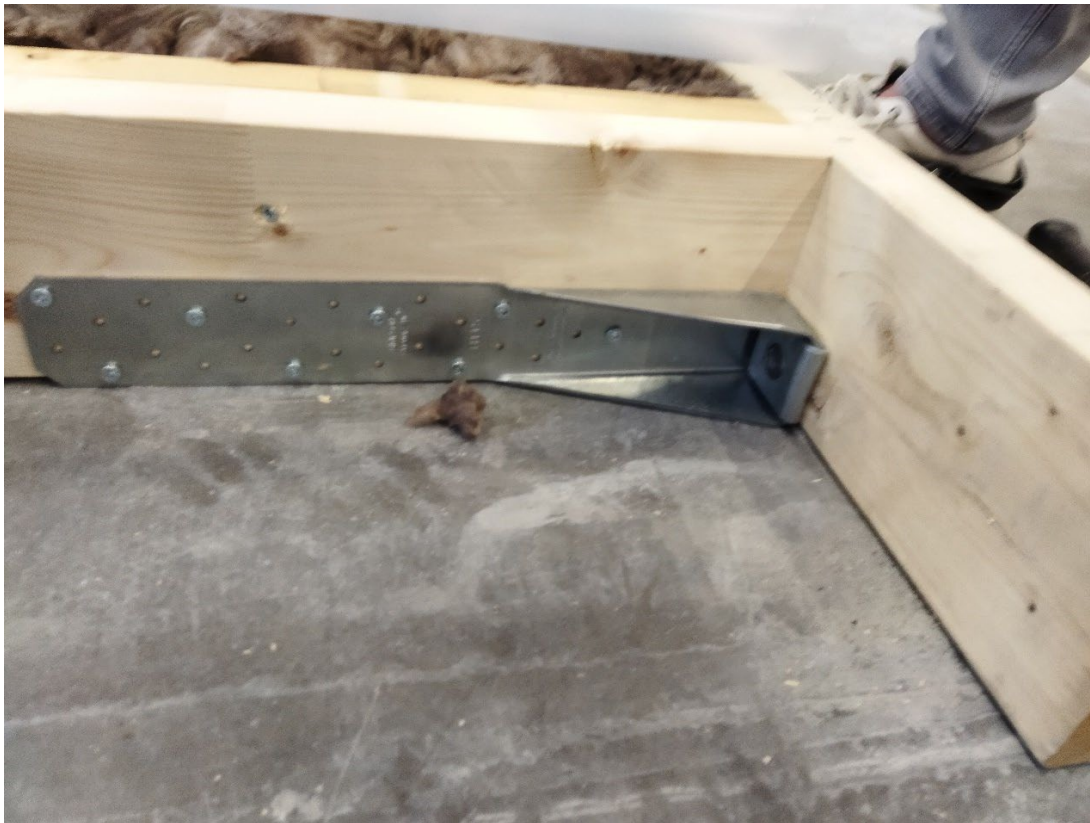
Foto C. 4: Platzierung der Klammern
